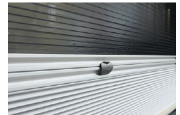
断熱性が高く結露のしにくいアクリル2重窓には遮光ブラインドとバゲネットが内蔵されています。
